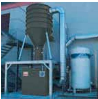
Filterzyklon auf einer Stahlkonstruktion
