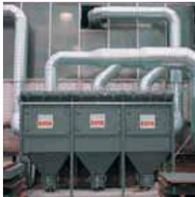
Modular aufgebaute Filtereinheit
