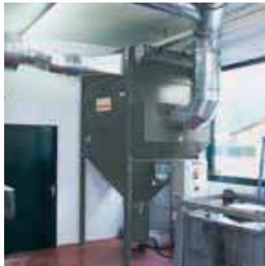
Filtereinheit mit separat gestelltem Ventilator
