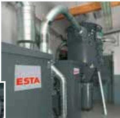
Seitenkanalverdichter mit Filterzyklon
