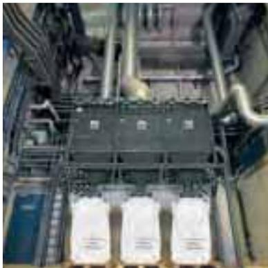
Zentrale Absauganlagen können von ihrem Aufstellort aus über ein Rohrleitungssystem an mehreren Maschinen parallel absaugen. Ob Grob- oder Feinstaub, nass oder trocken, Dampf oder Rauch – ESTA Absauganlagen können den jeweiligen anwendungsspezifischen Erfordernissen angepasst werden.
