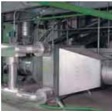
Rohrsystem für Abluft mit integriertem Kühler
