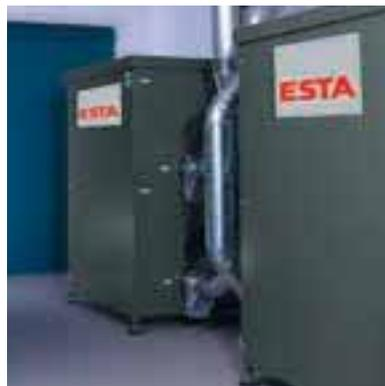
Zwei Seitenkanalverdichter in einer zentralen Staubsauganlage
