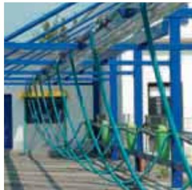
Fest installiertes Rohrsystem verbindet die Saugstellen mit dem Filterzyklon
