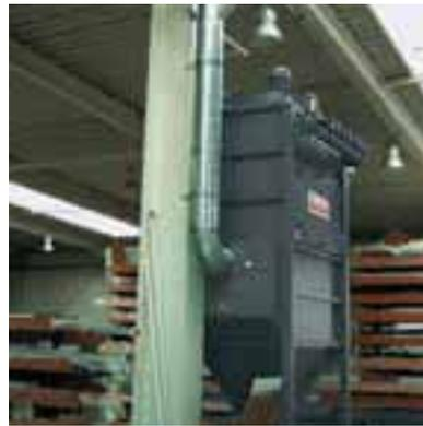
Absauganlage DUSTEX XS-17 mit aufgebautem Ventilator
