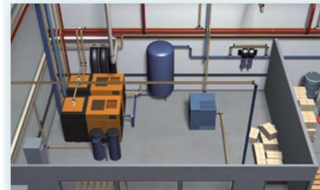
Ein herkömmlicher Kompressor mit externer Filterung und hohem Betriebsgeräuschpegel darf nicht im Produktionsbereich aufgestellt werden. Durch diese Regelung können erhöhte Installationskosten entstehen.
